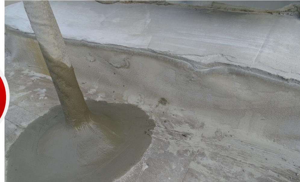
обработано **ARENA PolyElast PE** в 2 слоя
