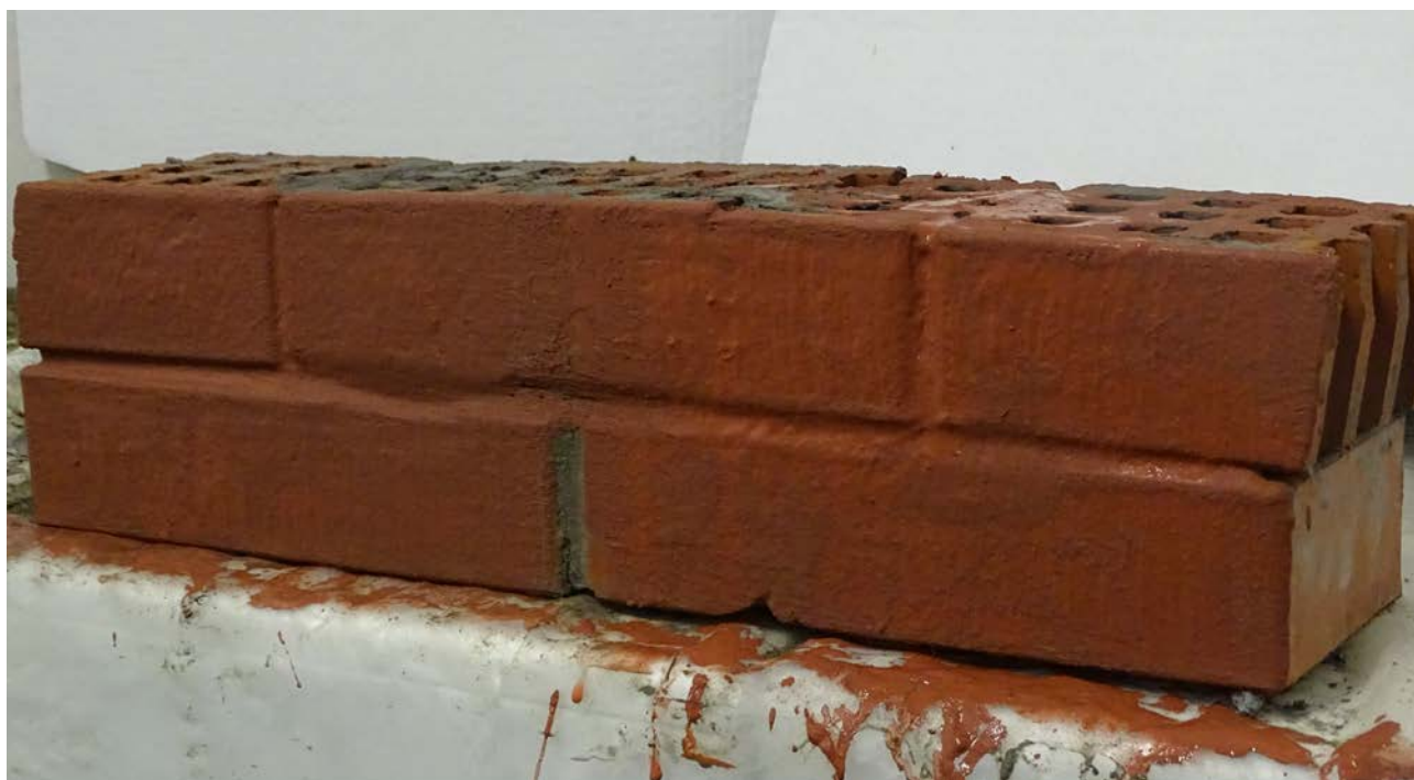
Рис 3. Вид элемента кирпичной стены после нанесения колерованной ARENA ProtectWall CM.
