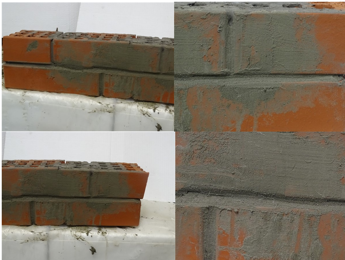
Рис 2. Вид элемента кирпичной стены после проведения конструктивного ремонта.
