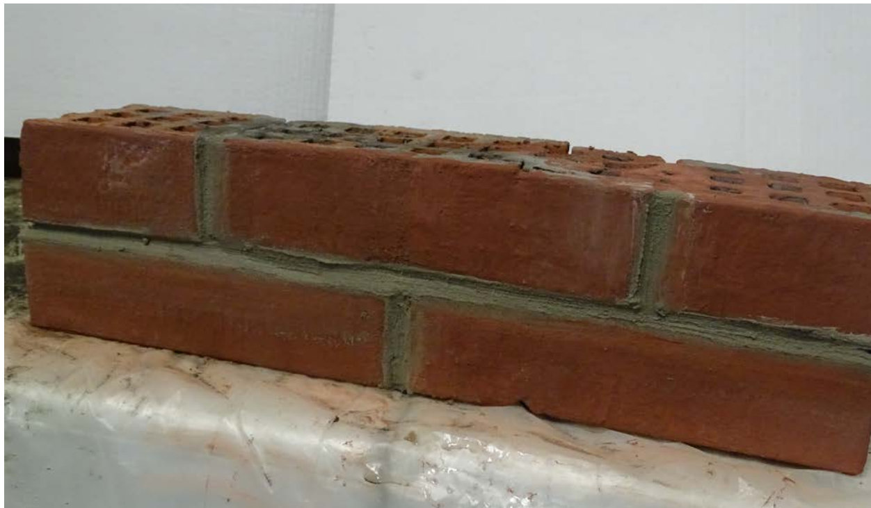
Рис 4. Окончательный вид элемента кирпичной стены после завершения восстановительного ремонта материалами ARENA FORCE
