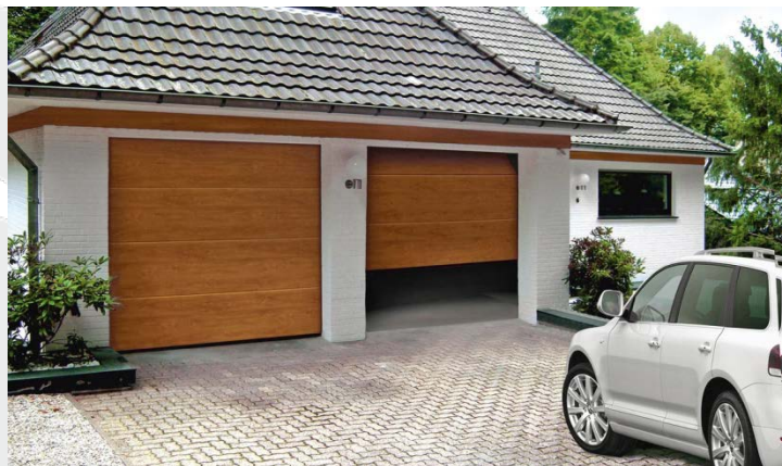
恢复停车场的入口
