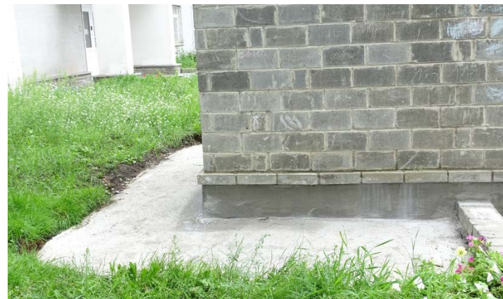
通风竖井混凝土盲区改造
