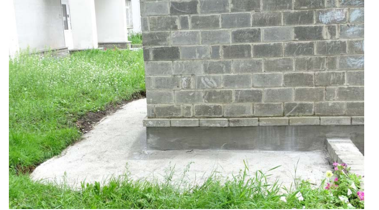
Havalandırma menfezlerinin beton kör alanının onarımı
